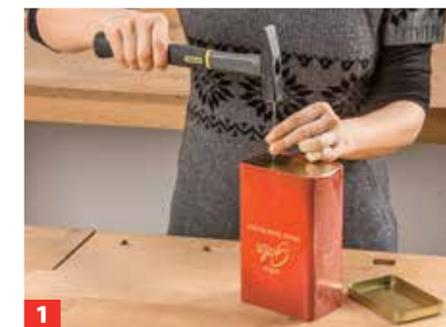
**1** Metalldose gut auswaschen. Mit einem dicken Nagel nach Bedarf Abflöcher in den Boden schlagen.
